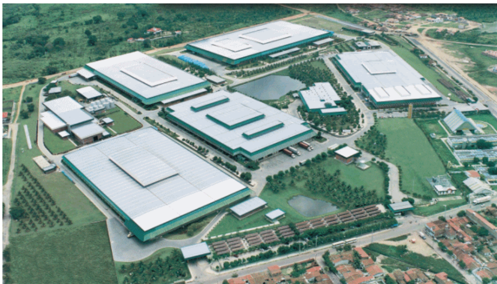
Figura 07 – Vista aérea do parque industrial da Grendene S/A em Sobral-CE. Fonte: http://www.grendene.com.br (2008).
